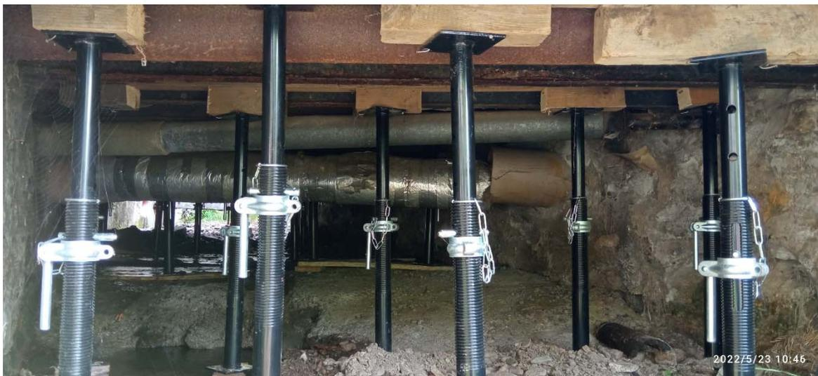
**Figura 7** – Intervento provvisorio di manutenzione canalizzazione e puntellamento
