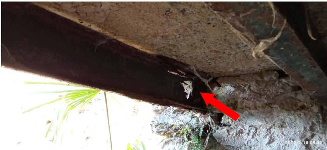
**Figura 5** – Stato di degrado delle travi della piattabanda
